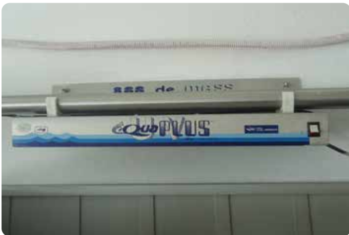
Figura 3. Desinfección física del agua mediante luz ultravioleta, que inactiva microorganismos sin alterar las propiedades químicas del agua.
